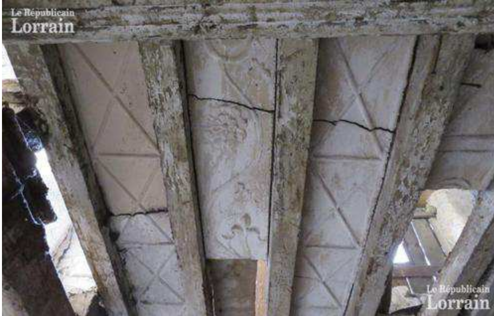
Une partie du plafond à estrich qui vient d'être découvert à Roupeldange. Photo RL
